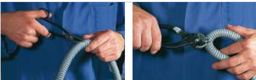
Cortar a través del revestimiento de plástico. Cut through the plastic sheathing.
